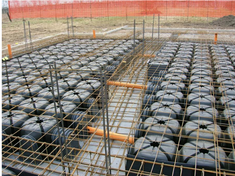
Figura 2 - Esempio di vespaio areato
