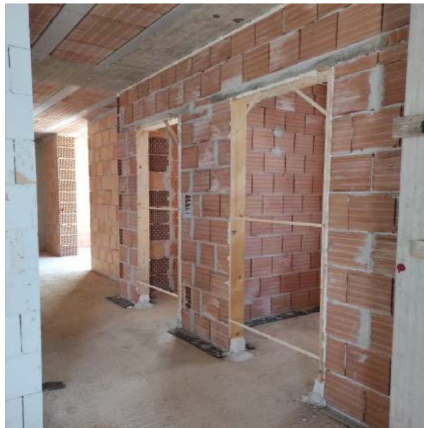
Figura 4 - Esempio tramezzature interne
