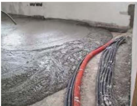
Figura 4 - Esempio posa di massetto
