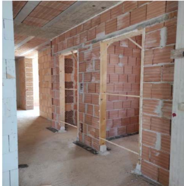
Figura 3 - Esempio tramezzature interne
