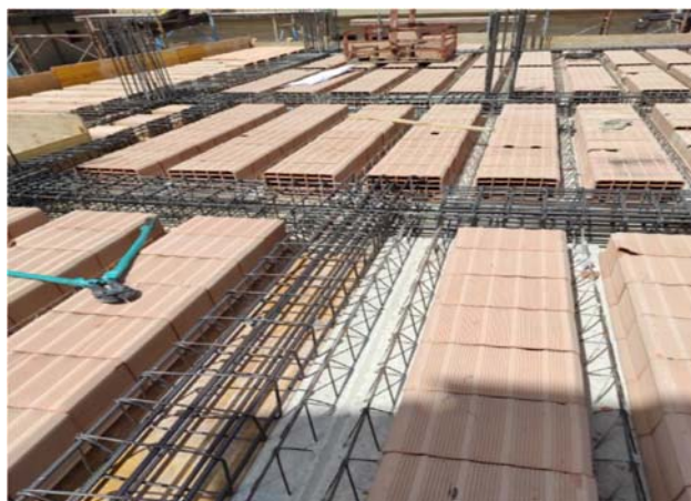
Figura 2 - Esempio struttura solai
