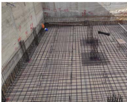
Figura 1 - Esempio strutture in elevazione
